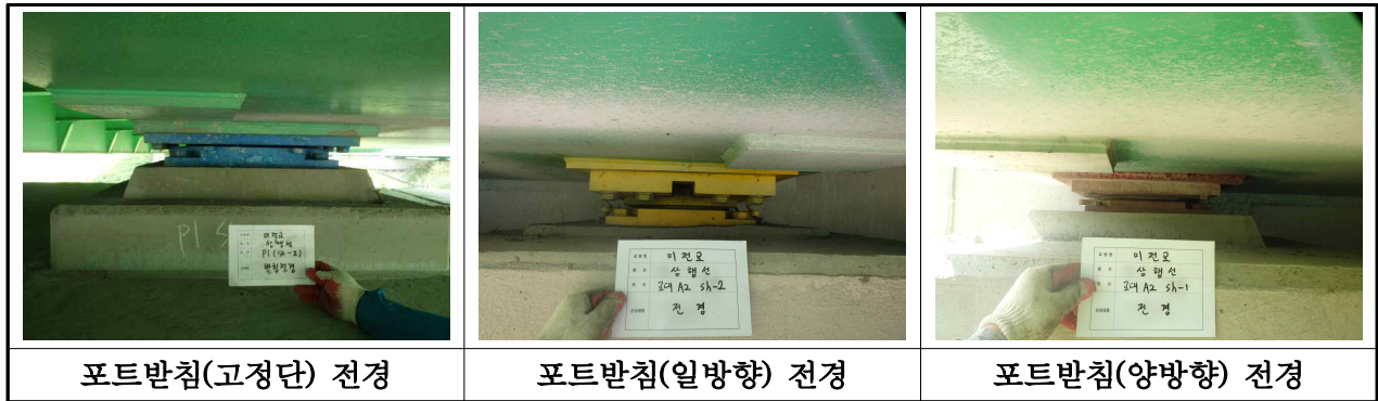
【사진 3.2.10】 교량받침 전경(대구)
