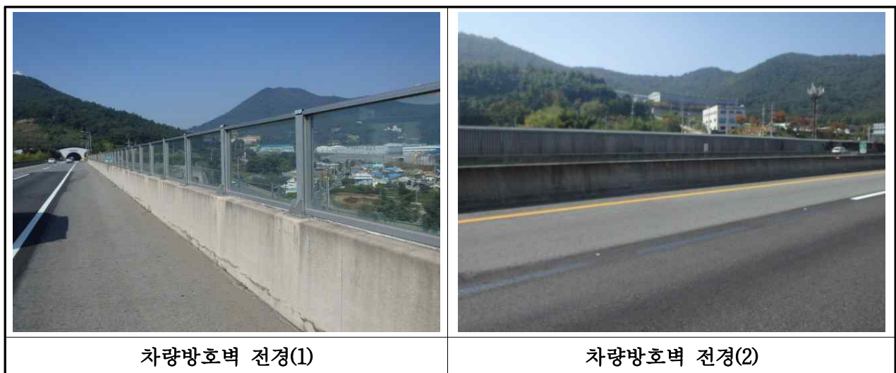
【사진 3.2.17】 방호벽 전경(대구)
