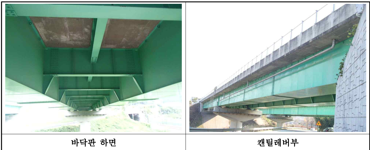
【사진 3.2.1】 바닥판 전경(대구)
