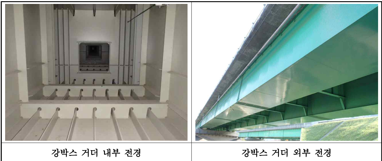
【사진 3.2.3】 강박스 거더 전경(대구)
