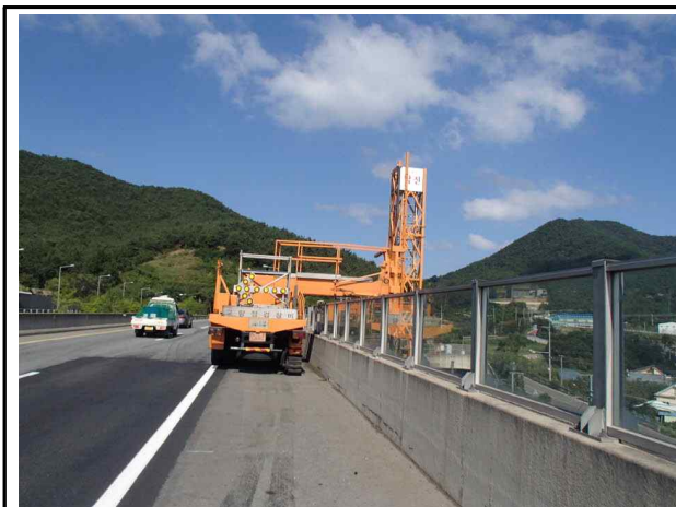
교량점검차를 이용한 조사
