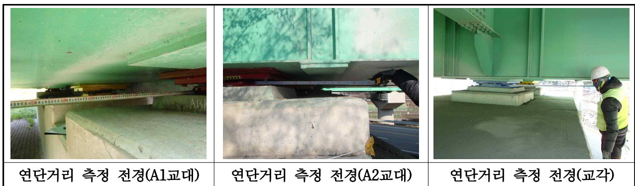
【사진 3.3.12】 연단거리 측정 전경
