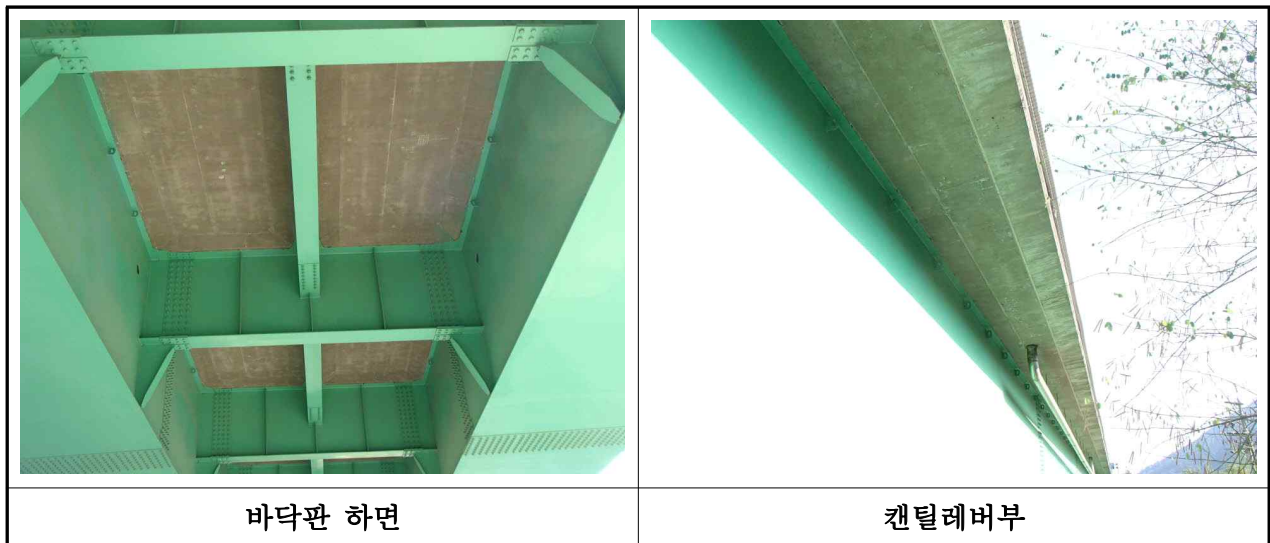
【사진 3.3.1】 바닥판 전경(부산)
