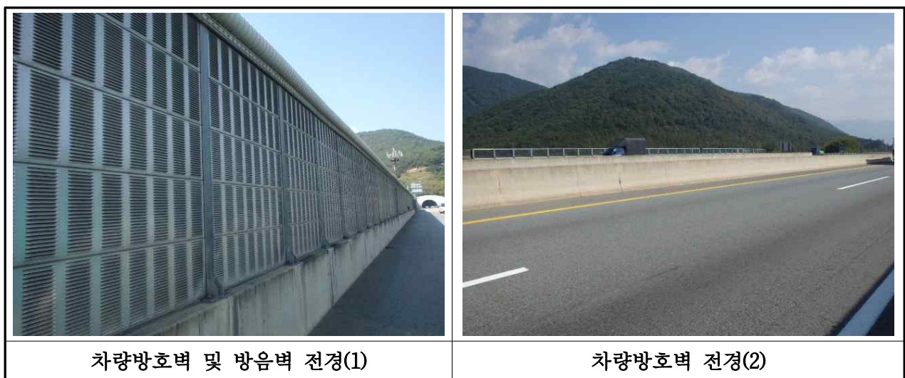
【사진 3.3.18】 방호벽 전경(부산)
