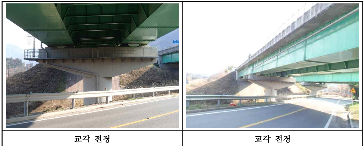
【사진 3.2.8】 교각 전경(대구)
