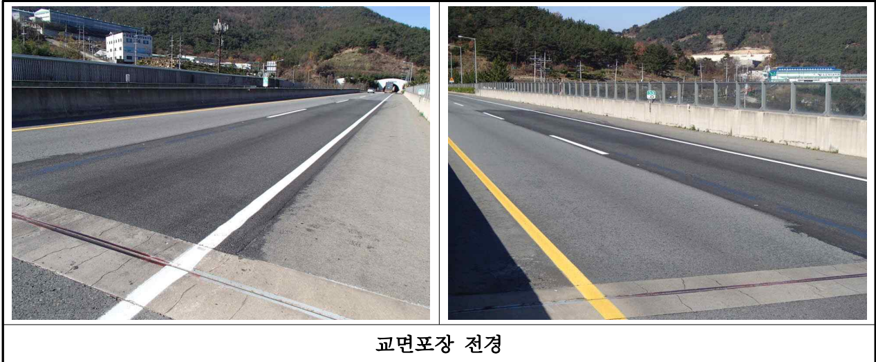
【사진 3.2.14】 교면포장 전경(대구)
