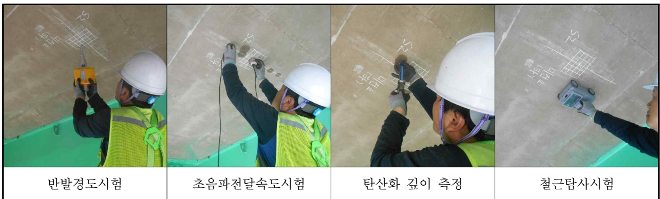
【사진 3.4.1】콘크리트 내구성조사 전경
