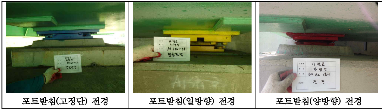
【사진 3.3.10】 교량받침 전경(부산)
