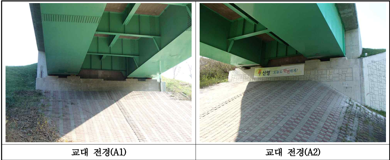
【사진 3.3.7】 교대 전경(부산)
