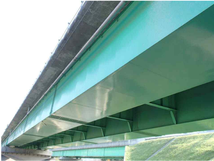
Steel Box Girder 외부 전경
